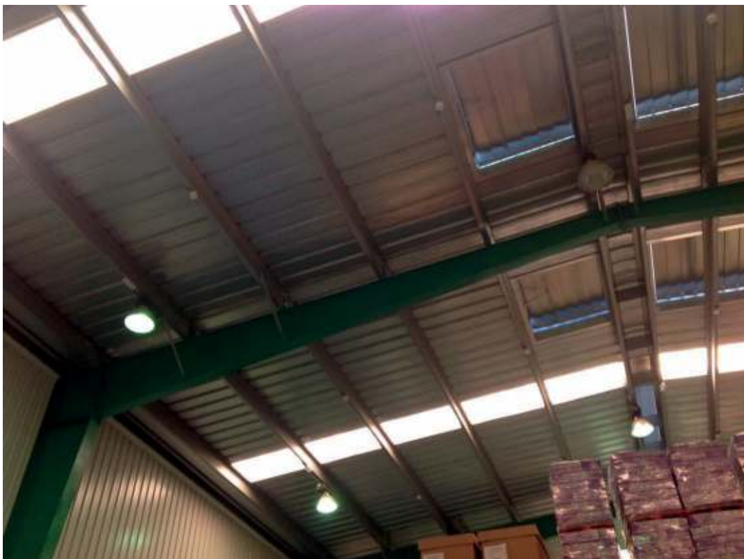
Exutoris en sostre de magatzem
