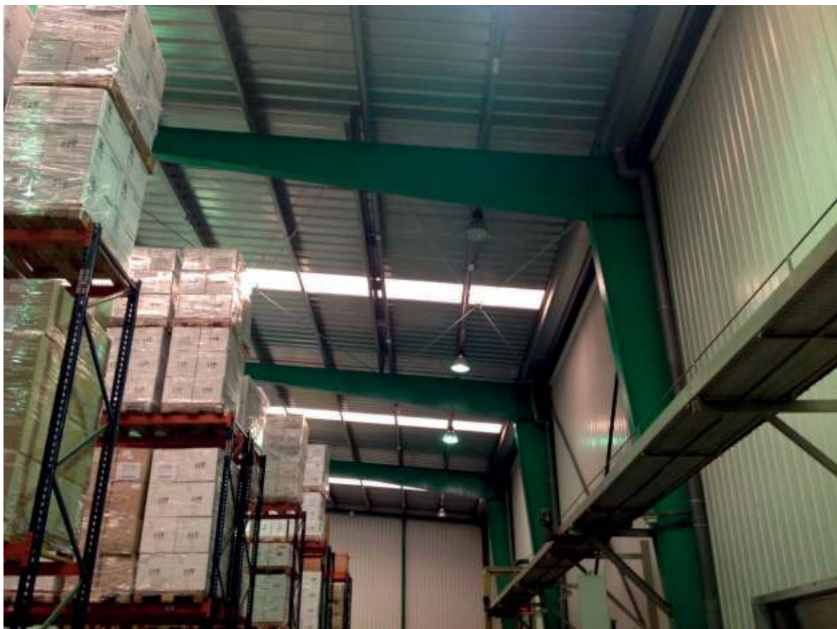
Estructura portant i pilars amb recobriment de pintura intumescent
