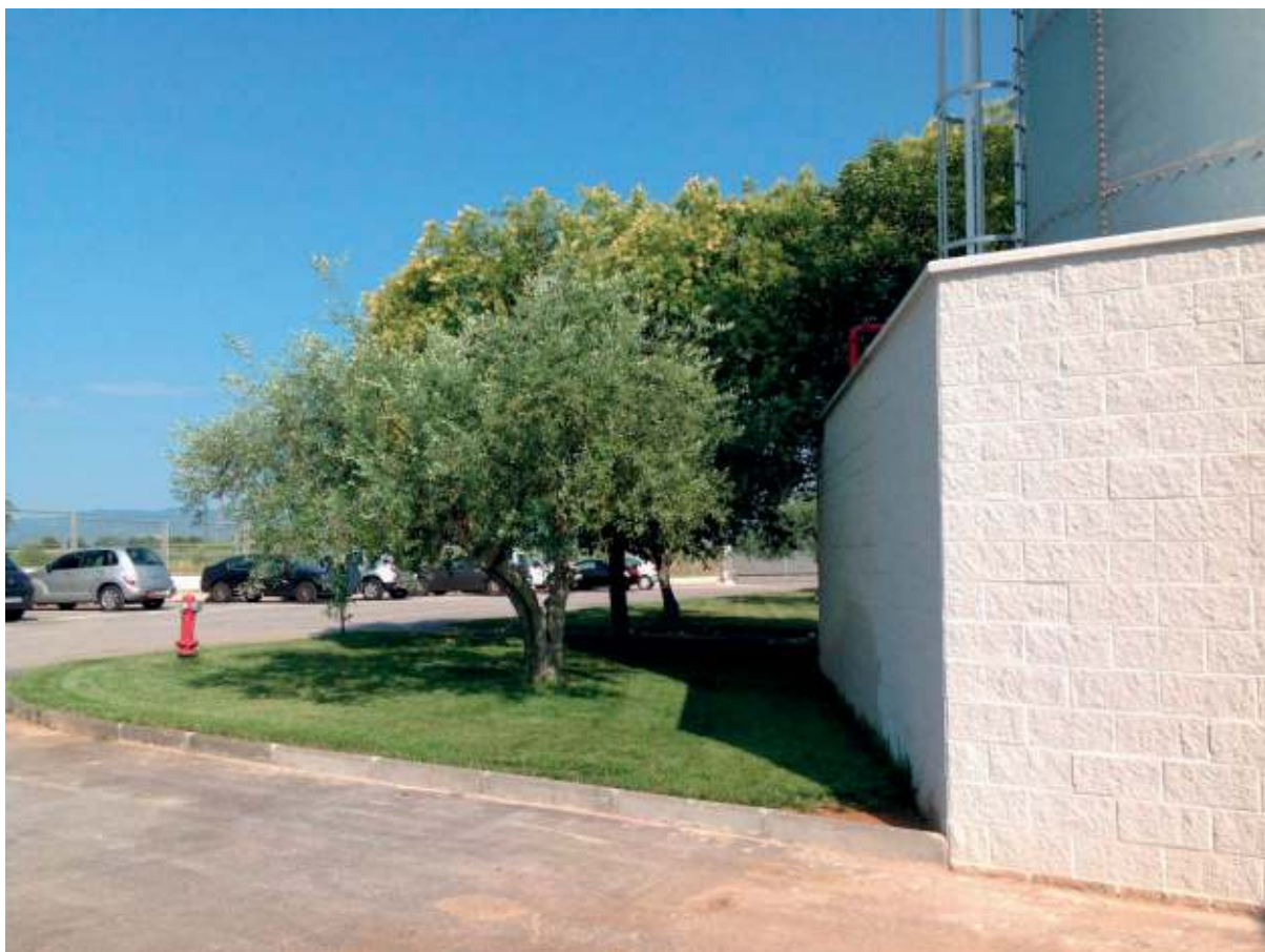
Hidrant en pati exterior instal·lacions
