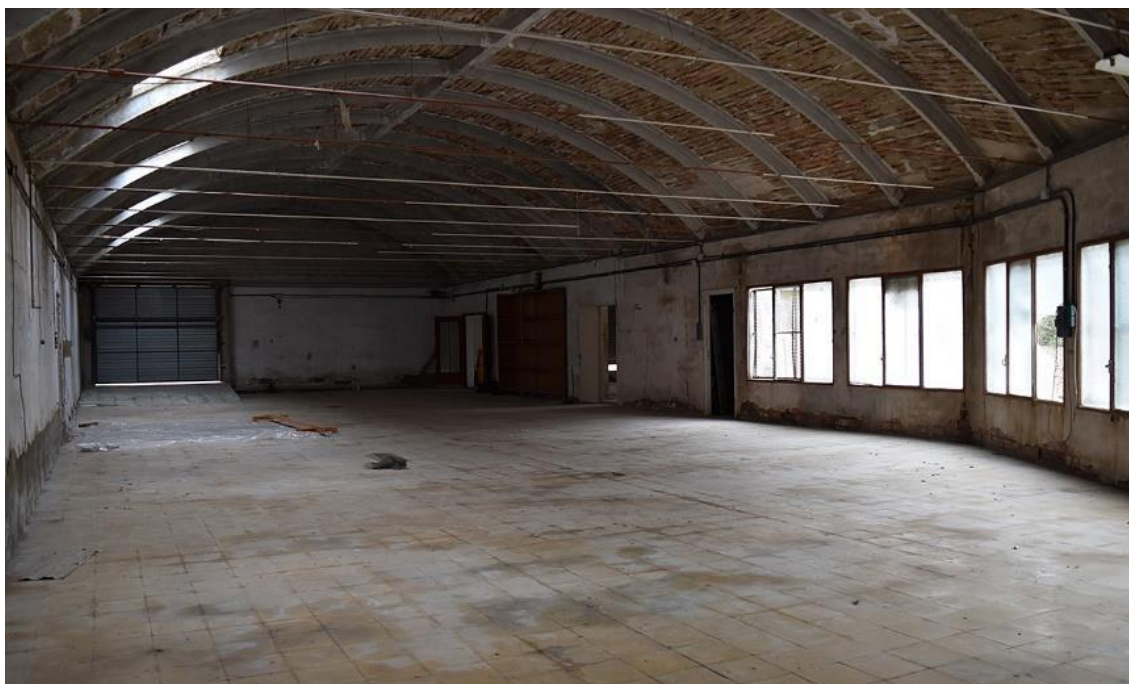
Sistema coberta costelles de formigó Nau 1
