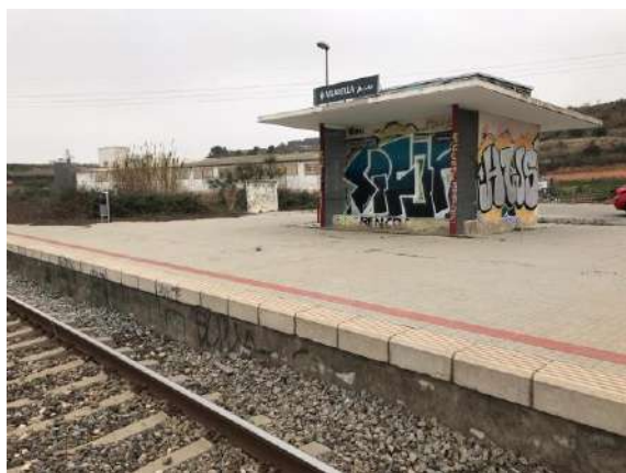
Foto 1: Situació de l'edifici de l'estació de Vilabella
