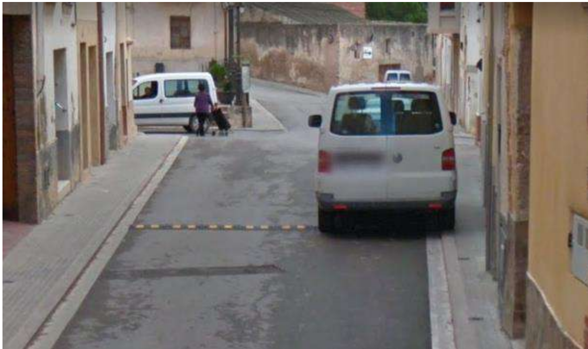
Fig. 3.56 Element reductor a la TV-2032. Font: Doymo
