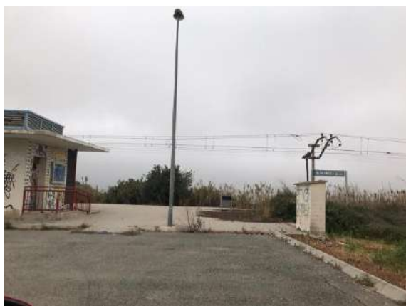
Foto 3: Accés a l'estació de Vilabella
